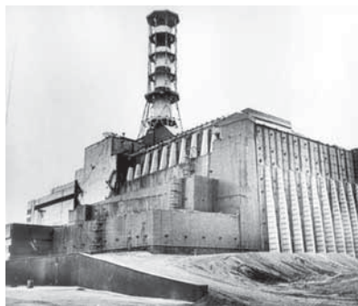
Объект «Укрытие» над разрушенным 4-м энергоблоком Чернобыльской АЭС
