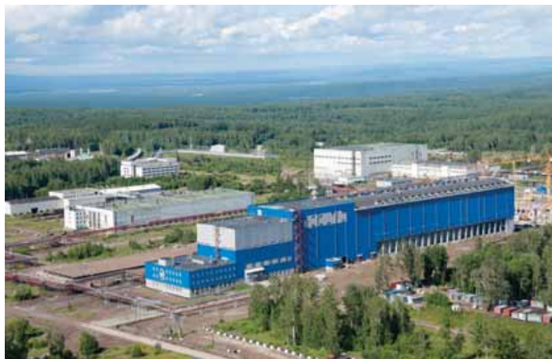
Пусковой комплекс сухого хранилища
